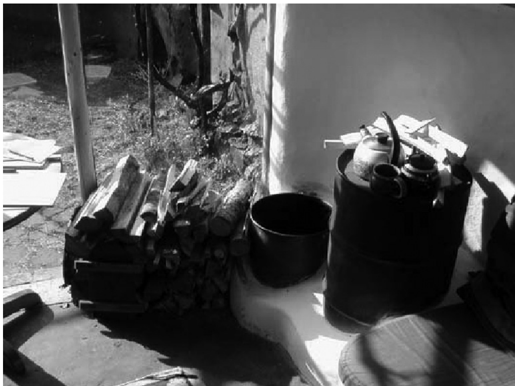
Deasupra: Soba-rachetă cu bancheta în partea din dreapta jos a fotografiei, din casa în care locuiesc Ianto Evans și Linda Smiley, a fost folosită mai bine de zece ani. Lemne de foc uscate, despicate în bucăți subțiri și aranjate la soare, butoiul mic pentru alimentare și butoiul radiant cuibărit în cob.
