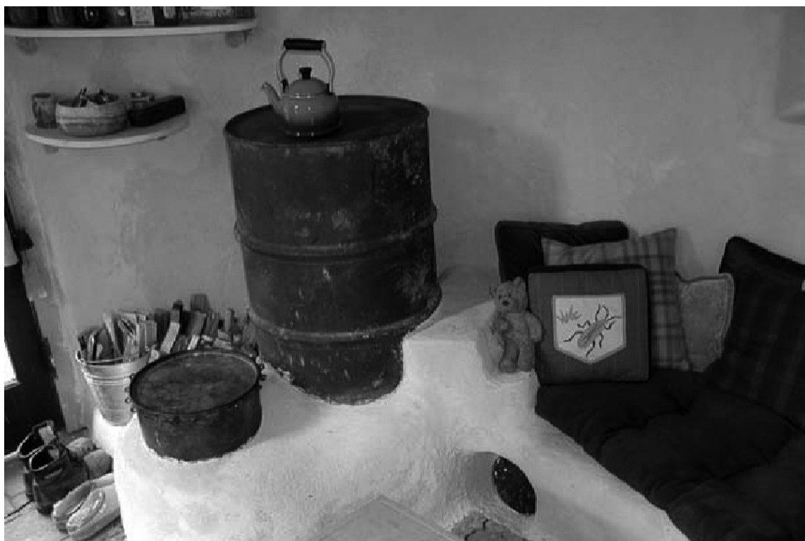
Deasupra: Soba-rachetă a lui Chris Reinhart. Se observă că butoiul radiant este lăsat neacoperit pe o suprafață destul de mare pentru a profita la maxim de căldura radiată.
