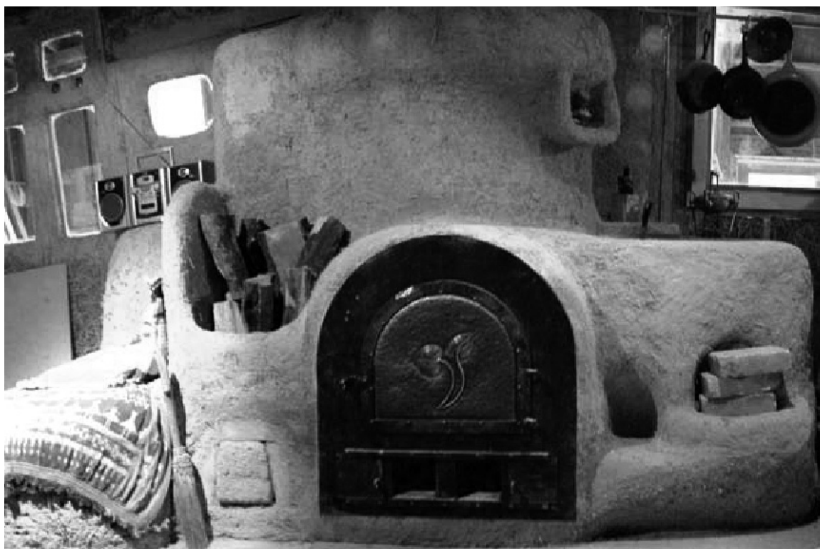
Dedesubt: Soba-rachetă a lui Kirk Mobert, cu suprafață pentru gătit în partea de sus a butoiului. Sub ușa de metal există două prize de aer rece. Locașul din banchetă păstrează lemnele de foc uscate.
