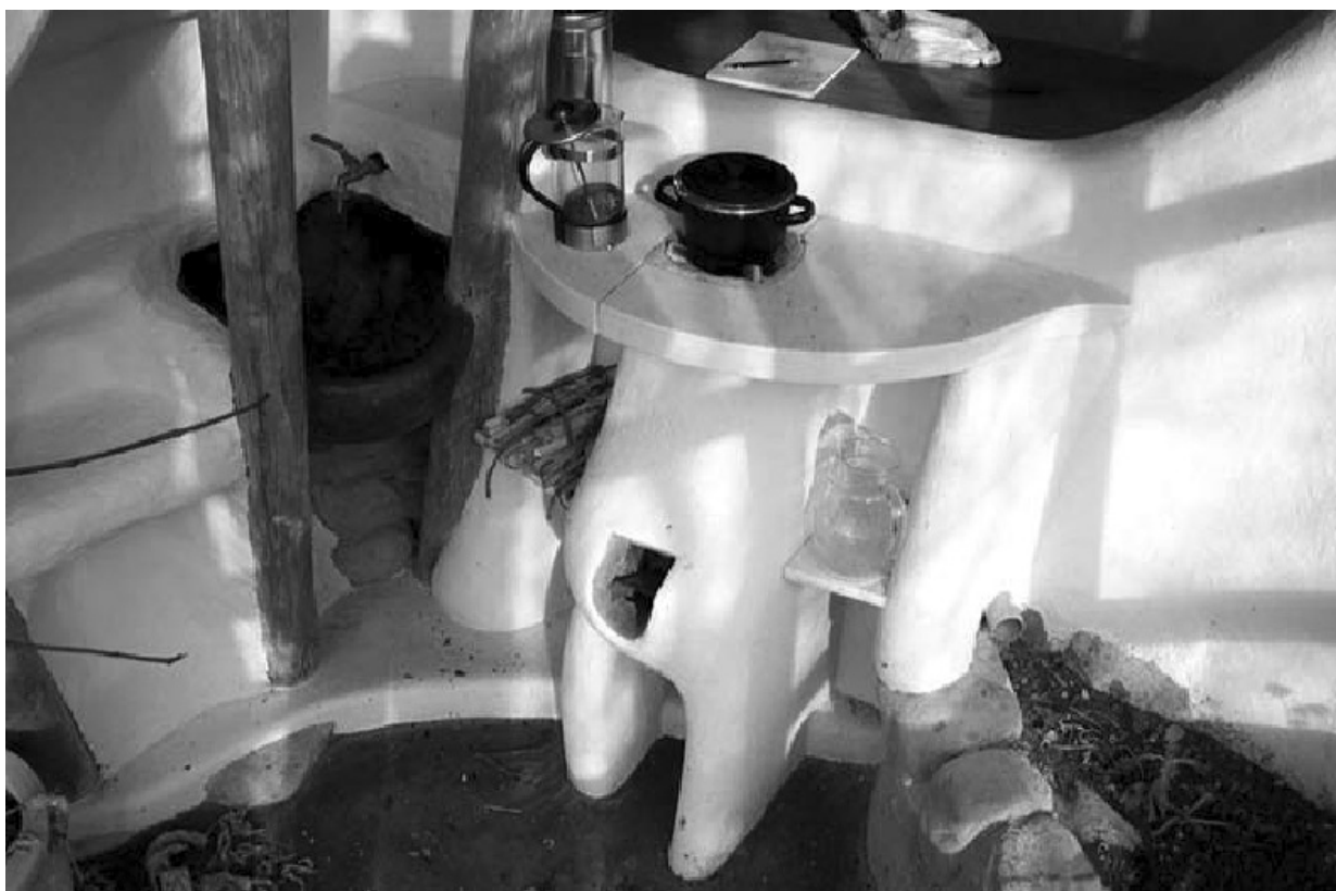
Micuța sobă-rachetă pentru cafea din biroul lui Flemming Abrahamsson (vedeți schița în secțiune, p. 79).
